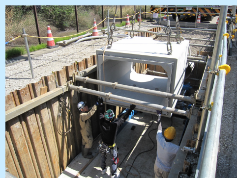
雨水BOXカルバート据付
