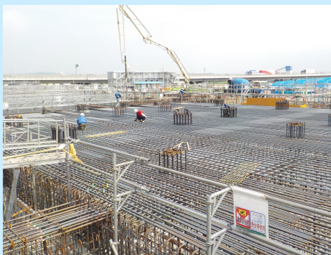
ごみピット及び炉室部基礎工事
